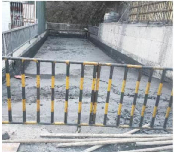
煤泥水收集池
