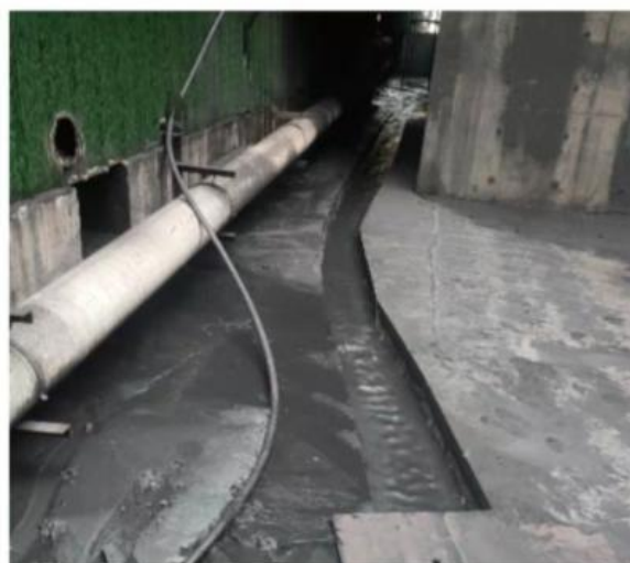
矿井水、生活污水回用管道及截排水沟（配套洗煤厂）
