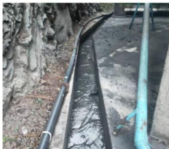
矿井水、生活污水回用管道及截排水沟（配套洗煤厂）
